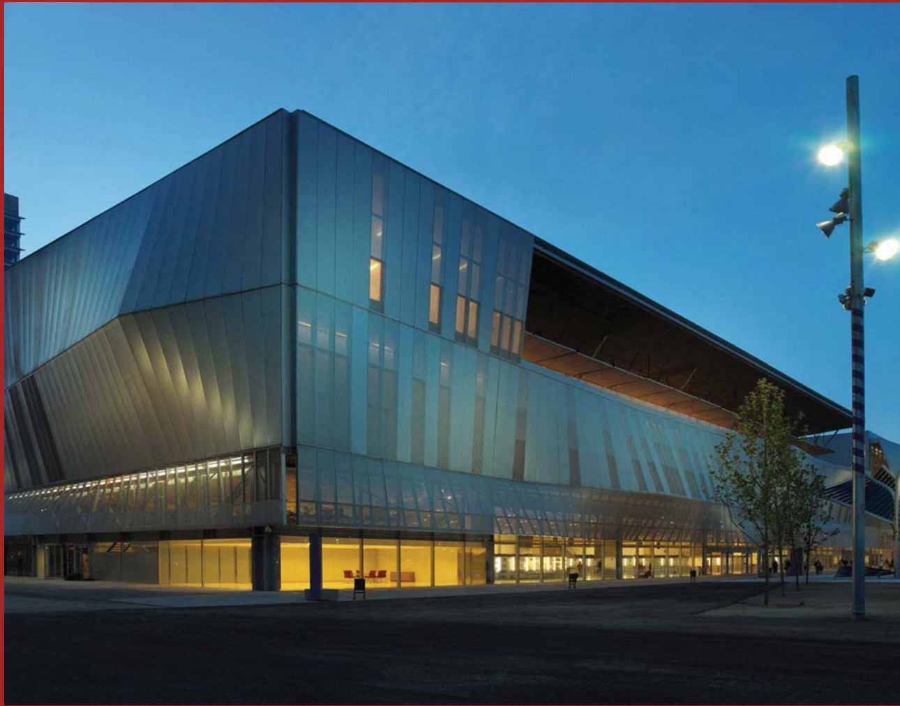
Centre Convencions Internacional Barcelona, Spain
