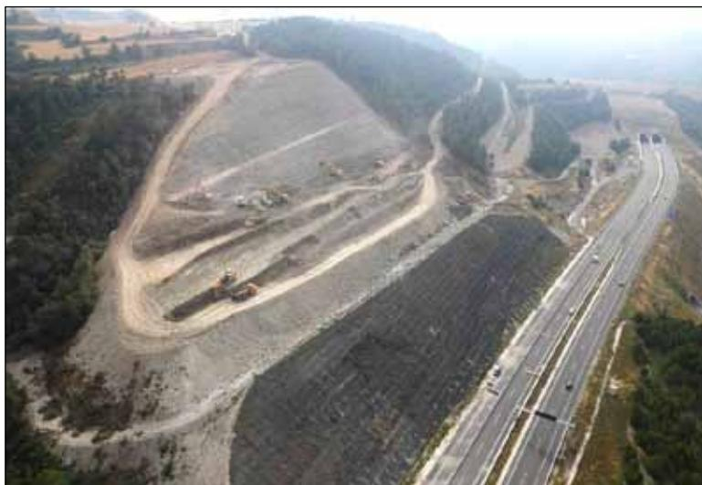
**Figura 12. Vista de los trabajos de movimiento de tierras en una fase intermedia de la reparación**
