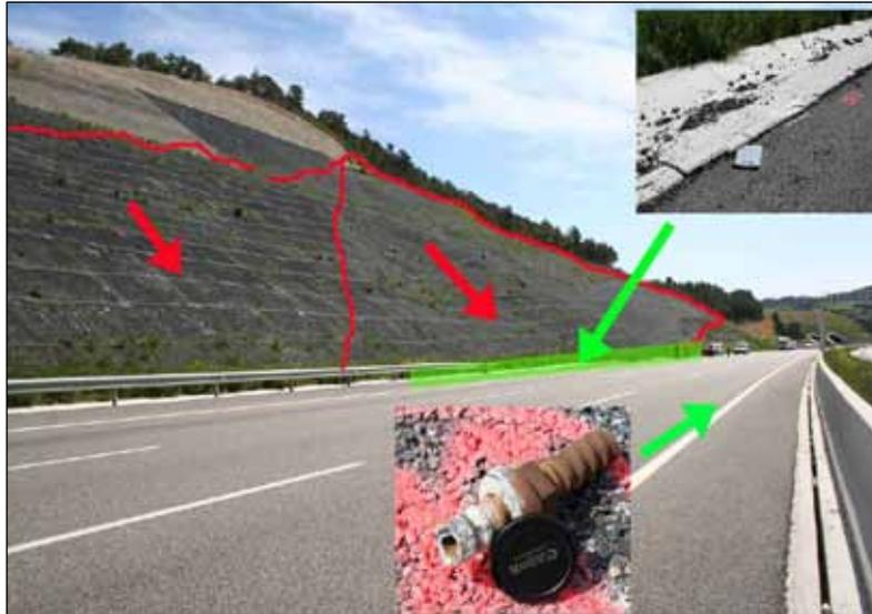
**Figura 2. Movimiento, deformaciones en la cuneta y cabezas de bulones proyectadas sobre la calzada**
