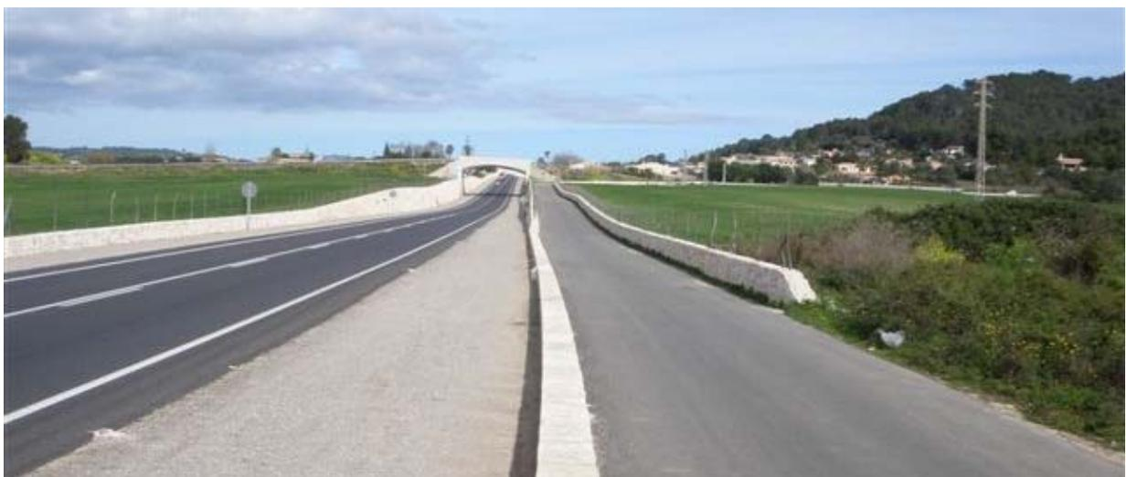
En las colinas arcillosas se puede considerar que toda el agua de lluvia se convierte en escorrentía que se va por las redes de torrentes hasta el mar. El agua se vehicula mediante las bermas y los paseos, auténticas cunetas planas que en este caso no infiltran, y se deben insertar cuidadosamente en la red de drenaje local. Aquí la zanja drenante se convierte en un dren sellado que sólo protege el subsuelo de la carretera, y se debe evitar que recoja la escorrentía.
