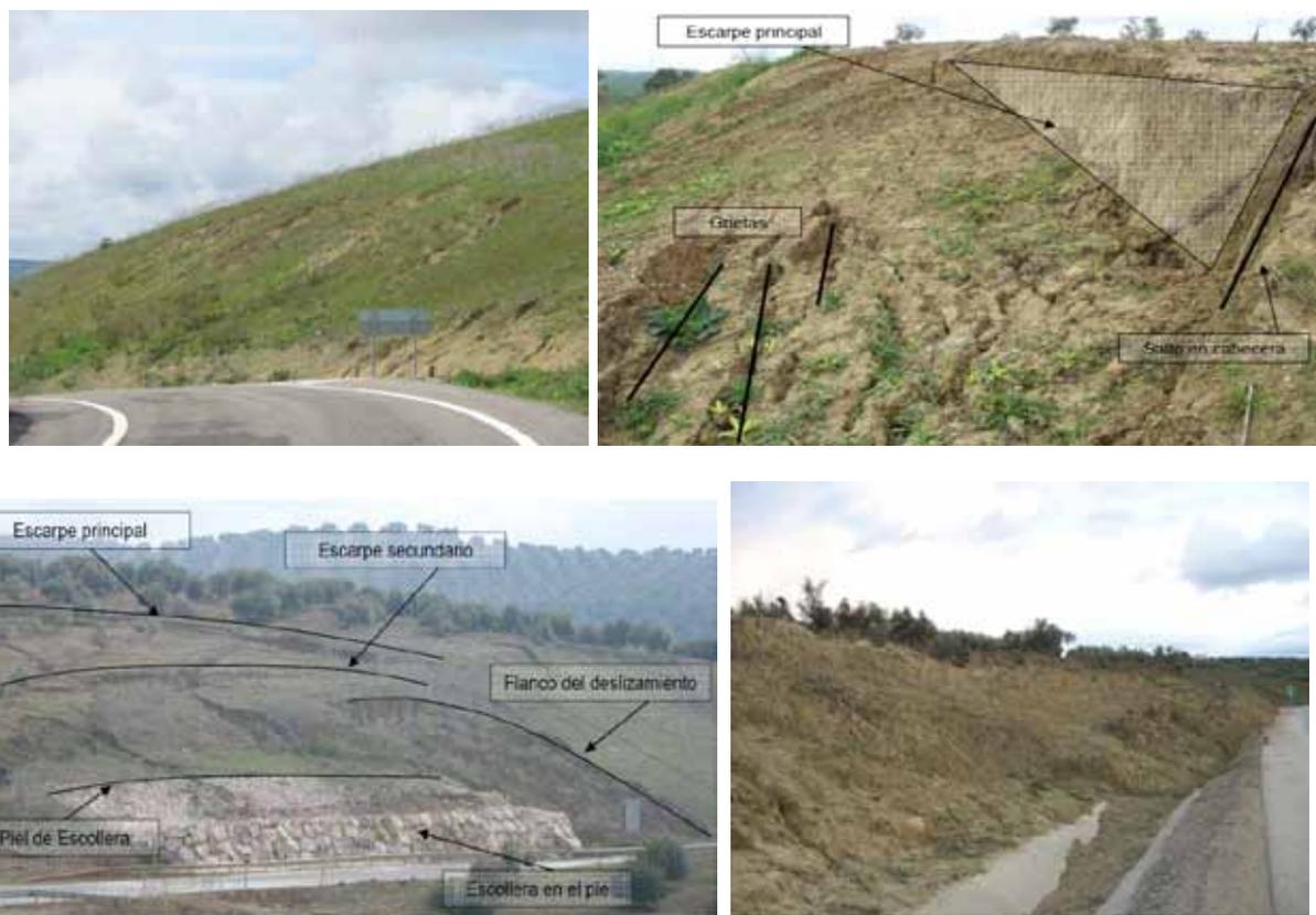
Figura 3.- Ejemplos de los distintos tipos de rotura de taludes actuales en las AAG y los medios de tratamiento empleados a) Deslizamiento reparado en el talud T-46 inventariado (12 m y 33°); b)
