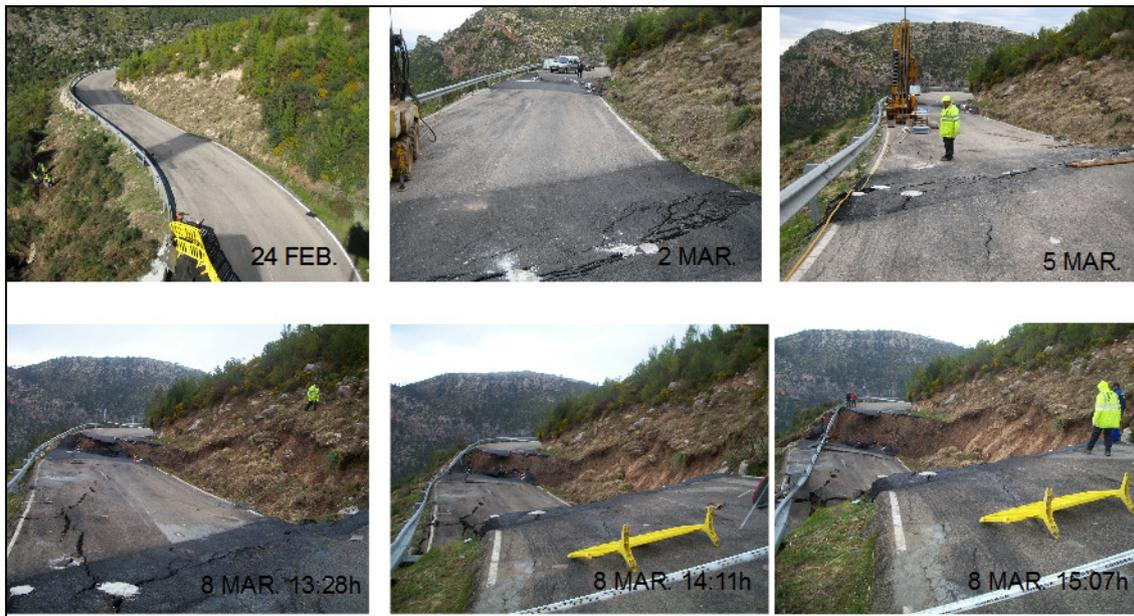
Figura 2. Evolución del deslizamiento entre febrero y marzo de 2010. Fotografías de COMASA.
