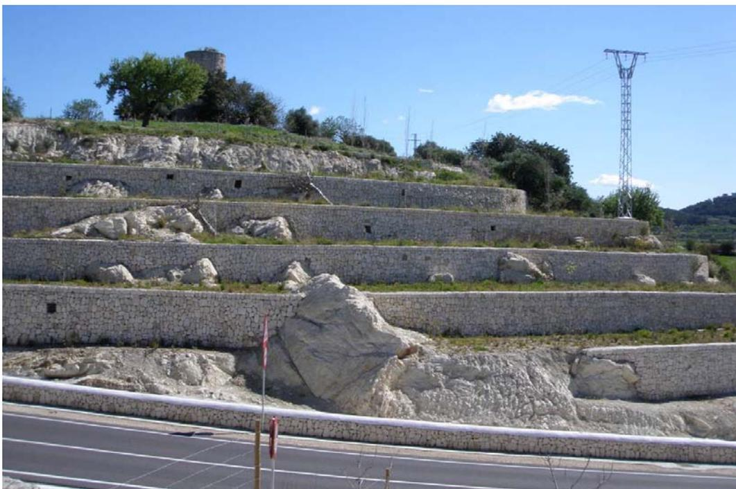
**FIGURA 4. EL DESMONTE DE LA RONDA DE MONTUÏRI.** Aquí la traza linda con las escuelas y el inicio de la población, por lo que la integración era fundamental. Se optó por solucionar el importante desmonte con una serie de bancales apoyados en las vetas rocosas, recreando los tradicionales, y se usó una pared con una coronación blanca como límite y defensa de la
