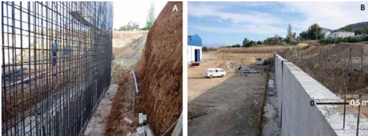
Figura 11.- Fases constructivas del muro de hormigón. A) Estructura armada con redondos de acero sobre base corrida. B) Fase final del muro de hormigón construido.
