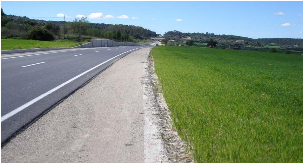
**FIGURA 3. RASANTEO DE LA CARRETERA DE MONTUÏRI A SANT JOAN. La elevación de la traza se limitó a una altura de un metro como máximo sobre el nivel de los campos adyacentes, y este desnivel se colmató con tierra vegetal.**
