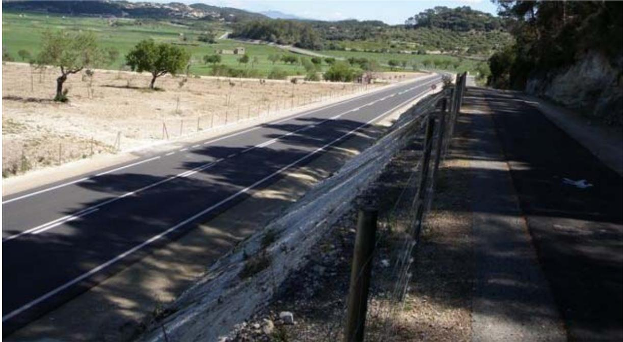
**FIGURAS 9 y 10. EL DRENAJE SUPERFICIAL DE LOS TERRENOS IMPERMEABLES.** Como concepto se intercepta mediante viales de servicio la escorrentía de las laderas situadas por encima de la carretera, y el caudal es conducido hasta cauces situados aguas abajo de la vía.
