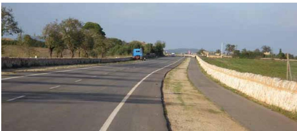
**FIGURA 2. SECCIÓN TIPO DE LA CARRETERA DE CAMPOS A SA RÀPITA.** El espacio entre paredes de cerramiento se ha optimizado, suprimiéndose cunetas y taludes, para disponer de bermas de seguridad y un paseo lateral.
