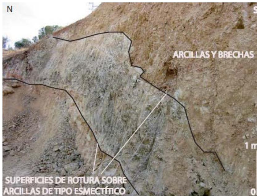
Figura 10.- Limpieza del talud para la construcción del muro de hormigón. Véase, la zona de color más claro entre las superficies de rotura, que corresponde a la lechada de cemento inyectada.
