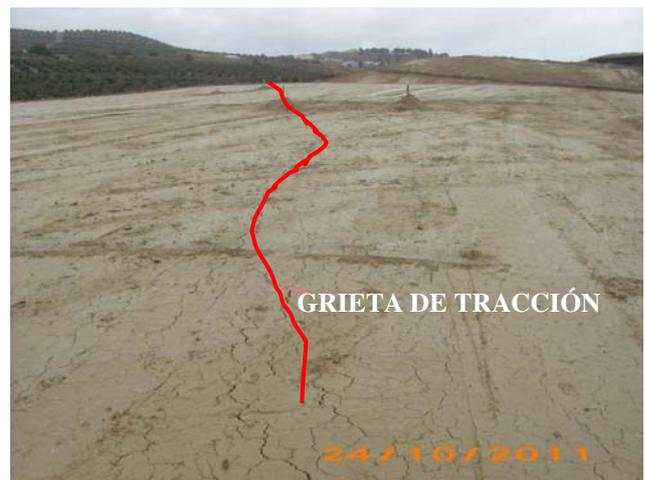
Fotografías 1 y 2. Vista del plano de discontinuidad estructural en las margas que parecía corresponder con la salida del plano de rotura en el arroyo Matadero. Grieta en coronación del terraplén.
