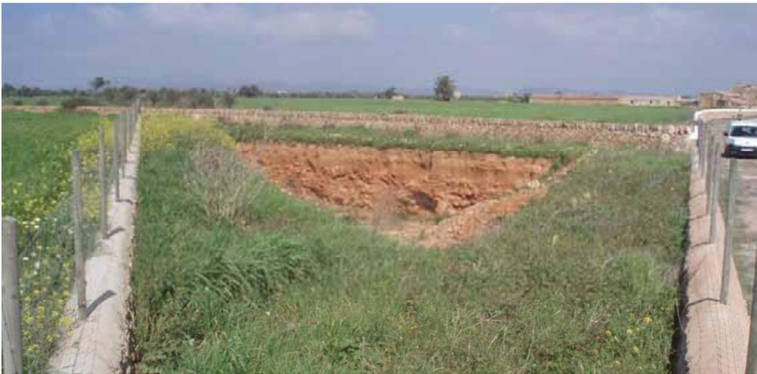
**FIGURA 7. Balsa de infiltración en Campos.** Está situada negociadamente en la linde de dos grandes fincas, y consiste en una mera excavación, en la que se puede apreciar el cambio de tierra vegetal a roca porosa. Recibe las aguas filtradas de la berma.
