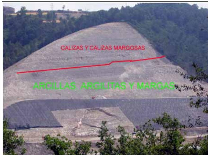
Figura 1. Detalle de la distribución de litologías en el desmorte
