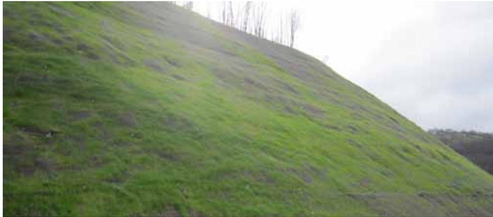
Figura 14. Estado del desmonte finalizado semanas después de aplicar la hidrosiembra
