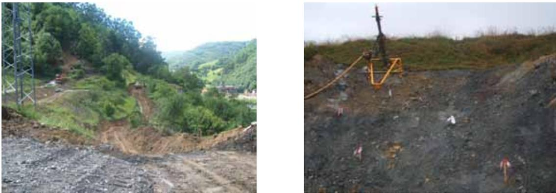
Figura 12. Trabajos de preparación de accesos y perforación de anclajes de coronación.
